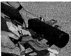
Taierea capetelor de conducta la unghi de 90 de grade.
